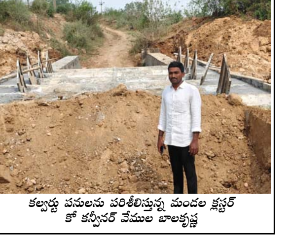
కల్వర్టు పనులను పరిశీలిస్తున్న మండల క్లస్టర్ కో కన్సిస్టర్ వేముల బాలకృష్ణ
