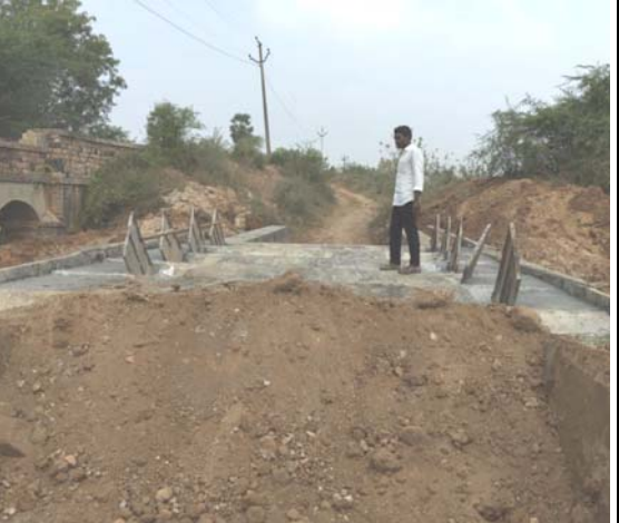
కల్వర్టు పనులను పరిశీలిస్తున్న మండల క్లస్టర్ కో కన్సిస్టర్ వేముల బాలకృష్ణ
